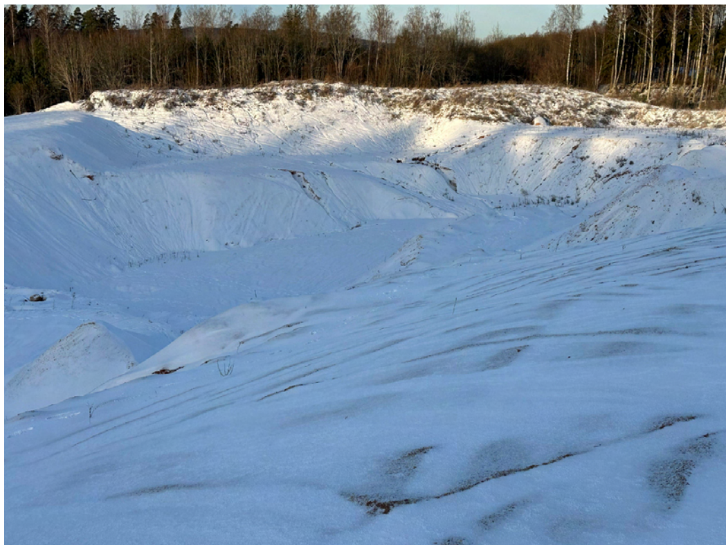
Foto 1. Vaade kaevealale kagust loode suunas.
